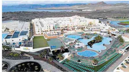
Vista parcial de de La Santa, desde el aire. COBER LANZAROTE
