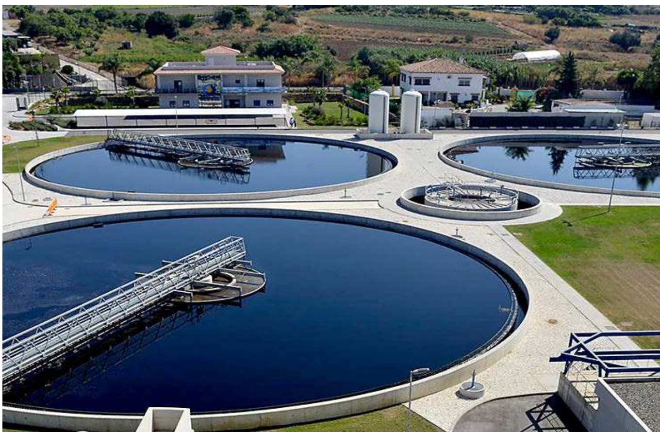
España sigue incumpliendo la Directiva 91/271 sobre tratamiento de aguas residuales. Europa Press
